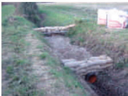
Сл. 38: Полнење на дренажен канал со чакал
