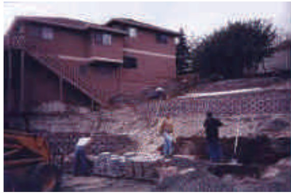
Сл. 5: Изградба на архитектонски објект
