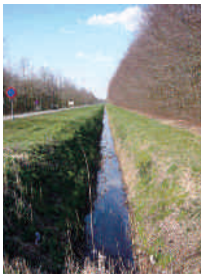
Сл. 35: Дренажен канал од отворен тип
