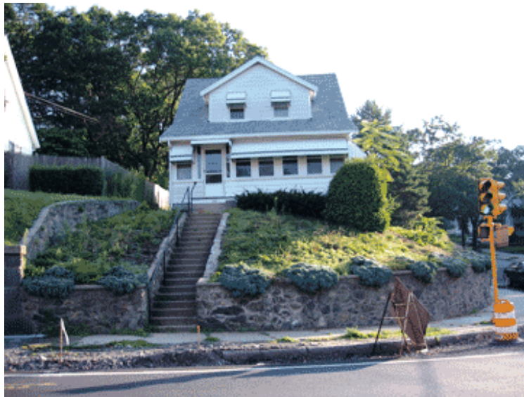
Сл. 331: Декорирање на потпорни ѕидови
