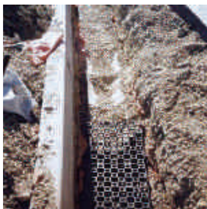
Сл. 45: Покривање на сито со чакал
