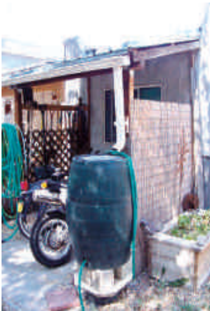
Сл. 80: Систем за наводнување со гравитационен пад
