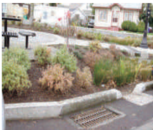
Сл. 52: Создавање испуст за вишокот вода кон шахтата
