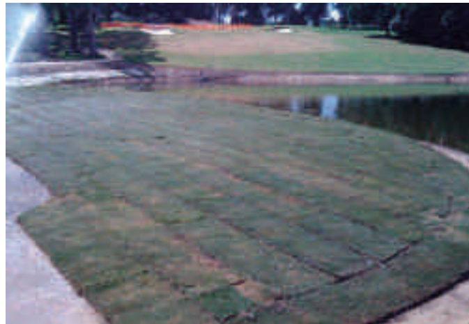
Сл. 168: Редување на тревните ролни во вид на тули
