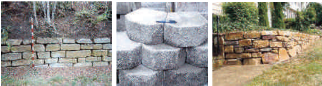
Сл. 98: Редување на камењата кај потпорните сидови
